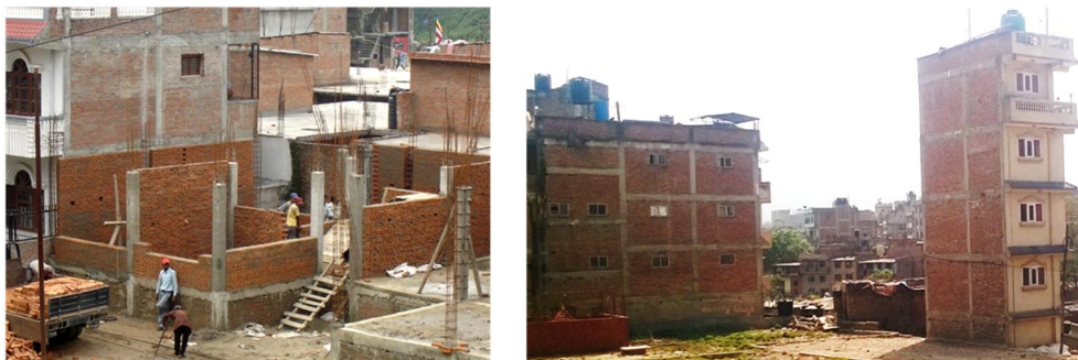
Rys. 6. Konstrukcje budynków na terenach sejsmicznych wykonanych z ram żelbetowych z murowanymi ścianami wypełniającymi (Bhaktapur, Nepal – rok 2016).
